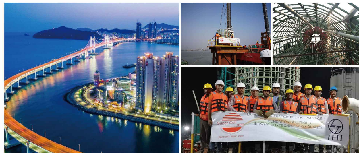
印度孟买越港跨海大桥 桩径2.15米 极限承载力10000吨
