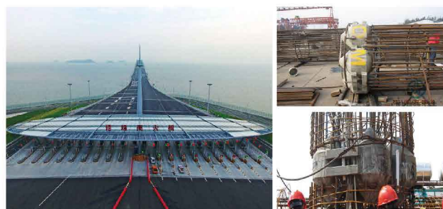
广东港珠澳大桥 桩径2.2米 极限承载力14000吨
