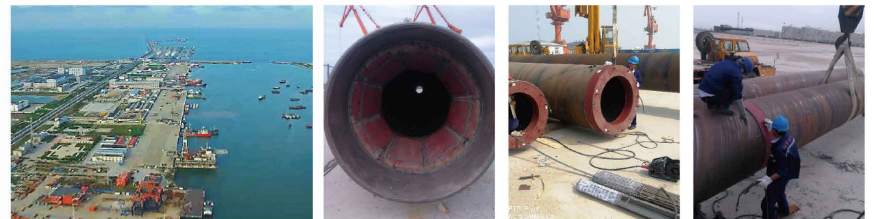
江西九江彭泽港区红光作业区综合枢纽码头 桩径1.35米 极限承载力 1400吨
