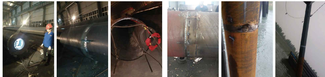
广东湛江港徐闻港 桩径1.5米 极限承载力2360吨
