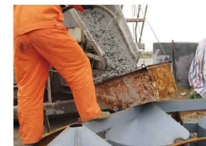
此结构体内部浇筑混凝土
