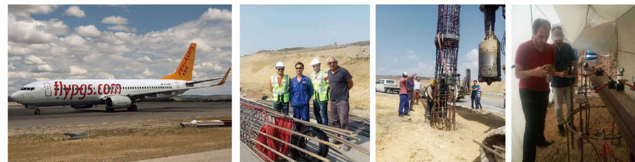
土耳其萨哈比国际机场 桩径1米 极限承载力2500吨
