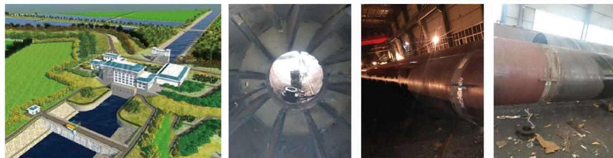
湖北洪湖东分块蓄洪工程内荆河节制闸 桩径1.0米 极限承载力1500吨
