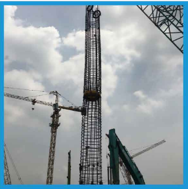
印尼美加达综合体项目 桩径1米，极限1000吨 (全球最大综合体房建项目)
