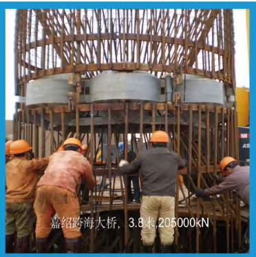
绍嘉大桥 桩径3.8米，极限20500吨 (在建时为最大单桩承载力试验项目)
