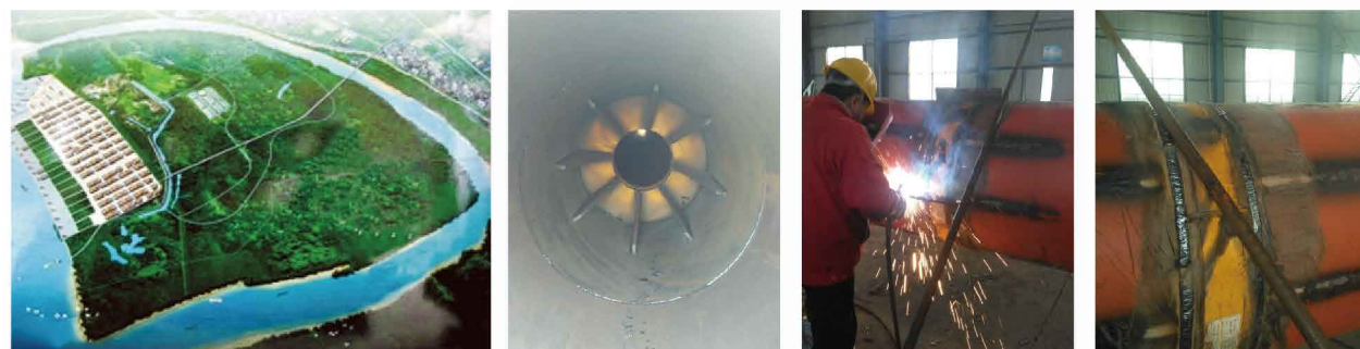
湖北武汉罗霍州码头 桩径1.2米 极限承载力 1100吨
