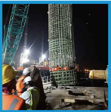
印度孟买大桥 桩径2.15米，极限10000吨 (印度最大吨位跨海大桥)
