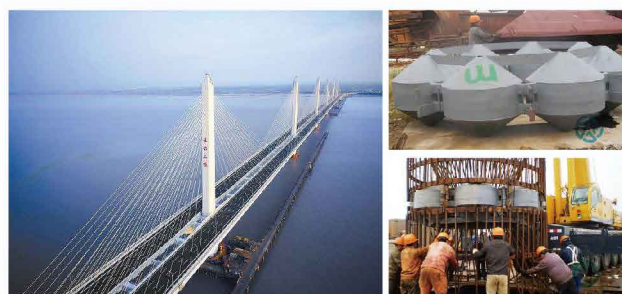
浙江绍嘉跨海大桥 桩径3.8米 极限承载力20500吨
