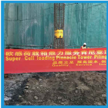
非洲肯尼亚Pinnacle大楼 桩径1.2米，极限2715吨 (非洲在建最高楼)
