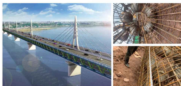
河南洛阳黄河特大桥 桩径2米 极限承载力7200吨
