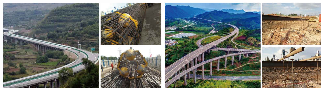
甘肃天北高速·北岸 桩径1.5米 极限承载力2400吨
