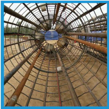
郑州黄河公铁大桥 桩径2米，极限7200吨 (全球最长公铁两用桥)
