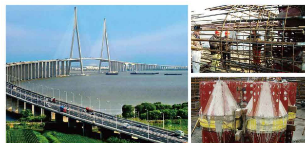
浙江杭州湾跨海大桥 桩径2.2米 极限承载力7000吨
