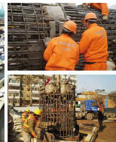
北京铁路局调度指挥中心 桩径2米 极限承载力4000吨
