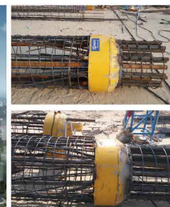
新疆乌鲁木齐中恒ICC 桩径1米 极限承载力2500吨
