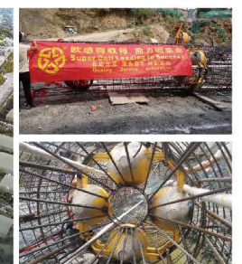
四川安防产业园 桩径1.8米 极限承载力5200吨
