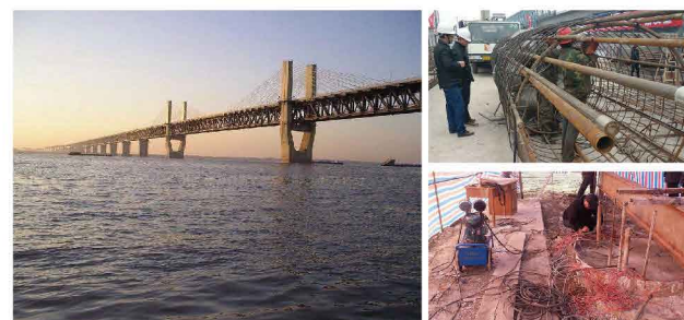
安徽芜湖长江特大桥 桩径1.8米 极限承载力12000吨
