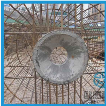
广西帝王大厦 桩径2.5米，极限9800吨 (广西柳州最高楼)
