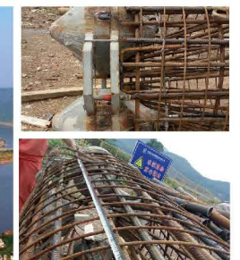
重庆市云阳房建项目 桩径2.5米 极限承载力6550吨
