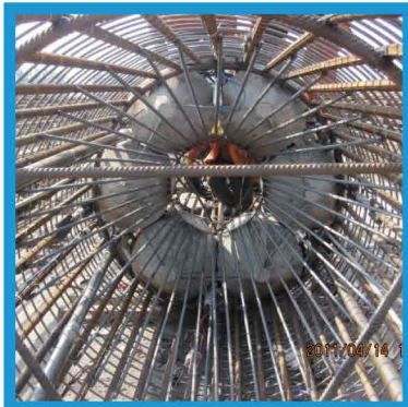
珠港澳大桥 桩径2.2米，极限14000吨 (最长世界跨海大桥)
