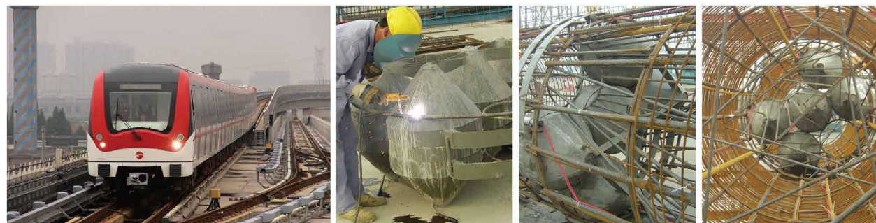
无锡地铁1号线 桩径2米 极限承载力2600吨
