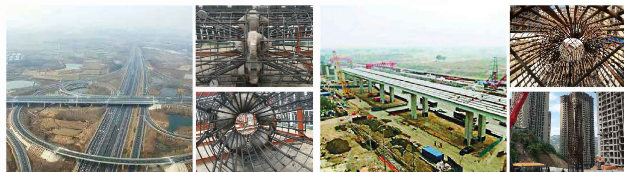
安徽芜湖市合芜高速连接线桩径1.8米 极限承载力4000吨
