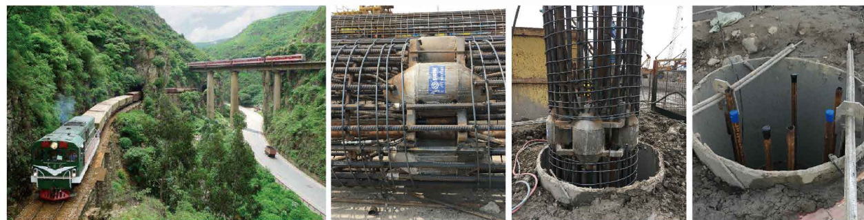
西藏拉林铁路工程 桩径1.5米 极限承载力4000吨
