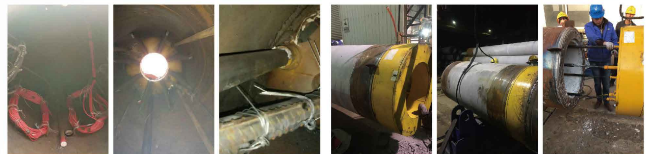
湖北武汉新港白浒山港区码头 桩径1.2米 极限承载力1300吨
