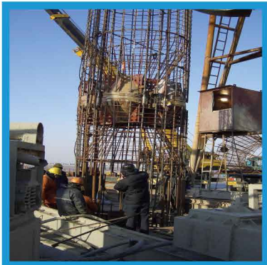
杭州湾大桥 桩径2.2米，极限7000吨 (在建时为全球最长跨海大桥)
