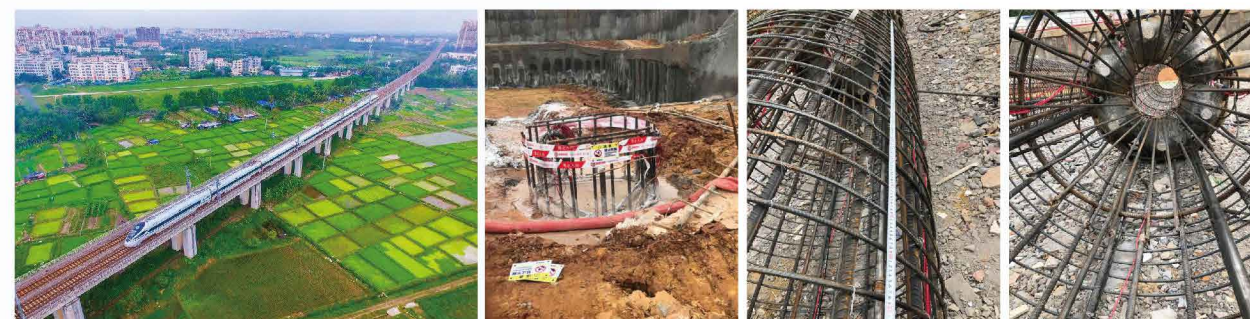
海南西环铁路 桩径2米 极限承载力3500吨
