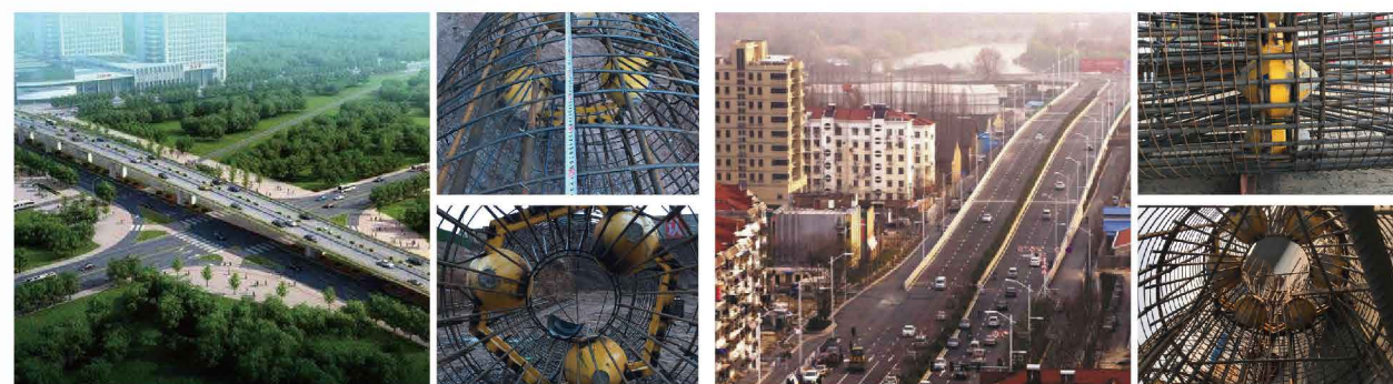
湖北黄石新港大道北延道路工程 桩径1.2米 极限承载力吨2200吨
