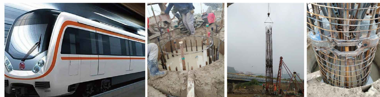
杭州地铁7号线 桩径1.8米 极限承载力6000吨
