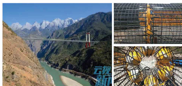
云南香格里拉至丽江高速公路标虎跳峡金沙江大桥 桩径2.5米 极限承载力6000吨
