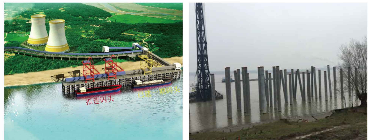
江西九江彭泽港区红光作业区综合枢纽码头 桩径1.35米 极限承载力 1400吨
